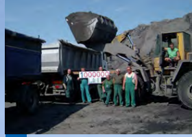
.A.S.A. estabiliza un estanque de lodos tixotrópicos en Mydlovary, República Checa
